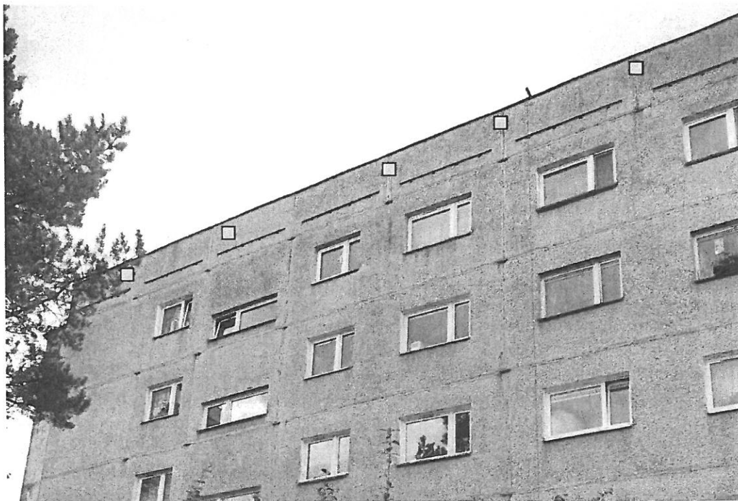
Fot. 8. Kraków, ul. Grota-Roweckiego 25, segment pierwszy, elewacja północna. Prostokątami wskazano miejsca, gdzie należy zamocować 5 budek dla wróbli.
