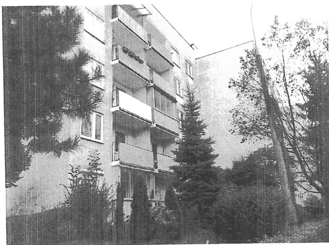
Fot. 9. Kraków, ul. Kobierzyńska 101, segment IV i III, elewacja wschodnia.
