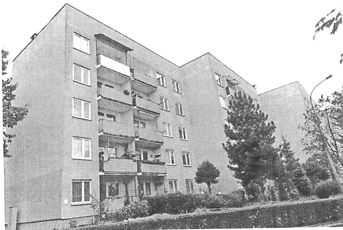
Fot. 8. Kraków, ul. Kobierzyńska 101, segment V, IV i III, elewacja wschodnia.
