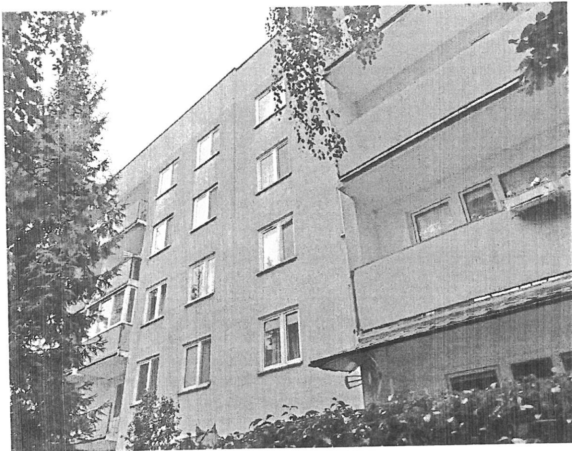
Fot. 10. Kraków, ul. Kobierzyńska 101, segment III, elewacja wschodnia.
