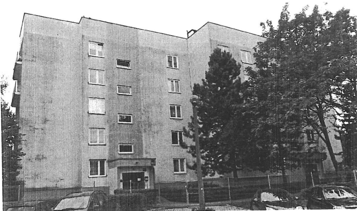
Fot. 2. Kraków, ul. Kobierzyńska 101, segment II i I, elewacja północna.
