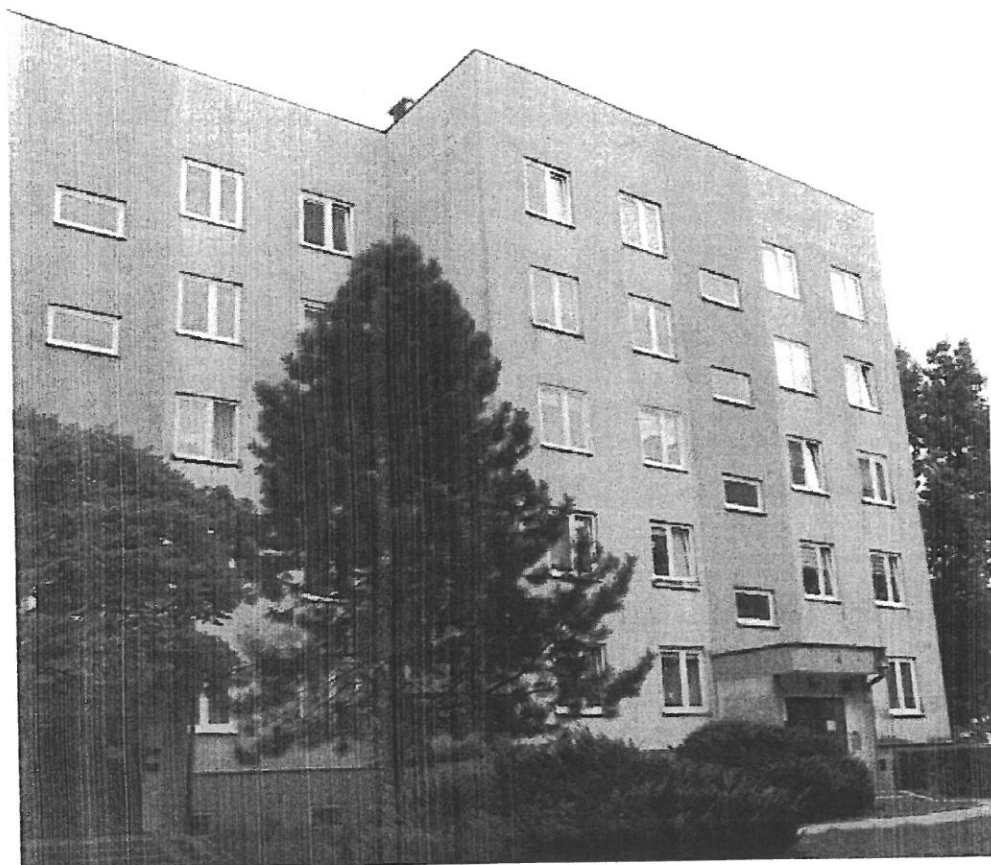
Fot. 6. Kraków, ul. Kobierzyńska 101, segment IV i V, elewacja zachodnia.
