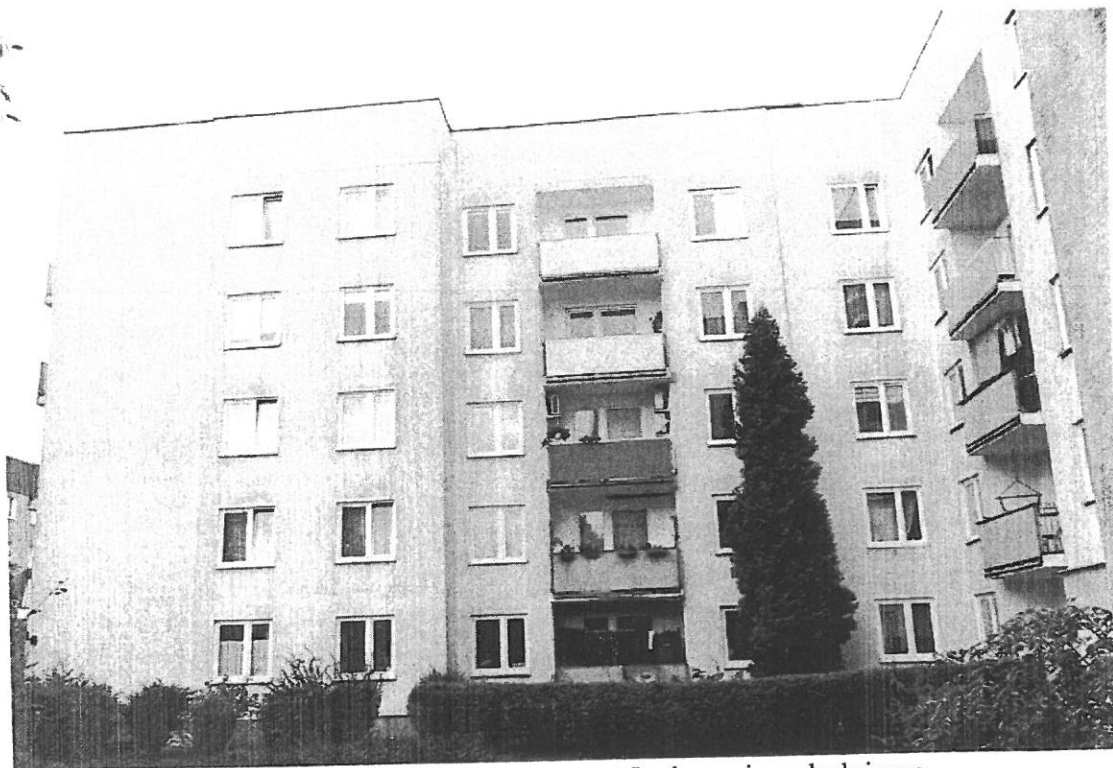
Fot. 4. Kraków, ul. Kobierzyńska 101, segment I, elewacja południowa.
